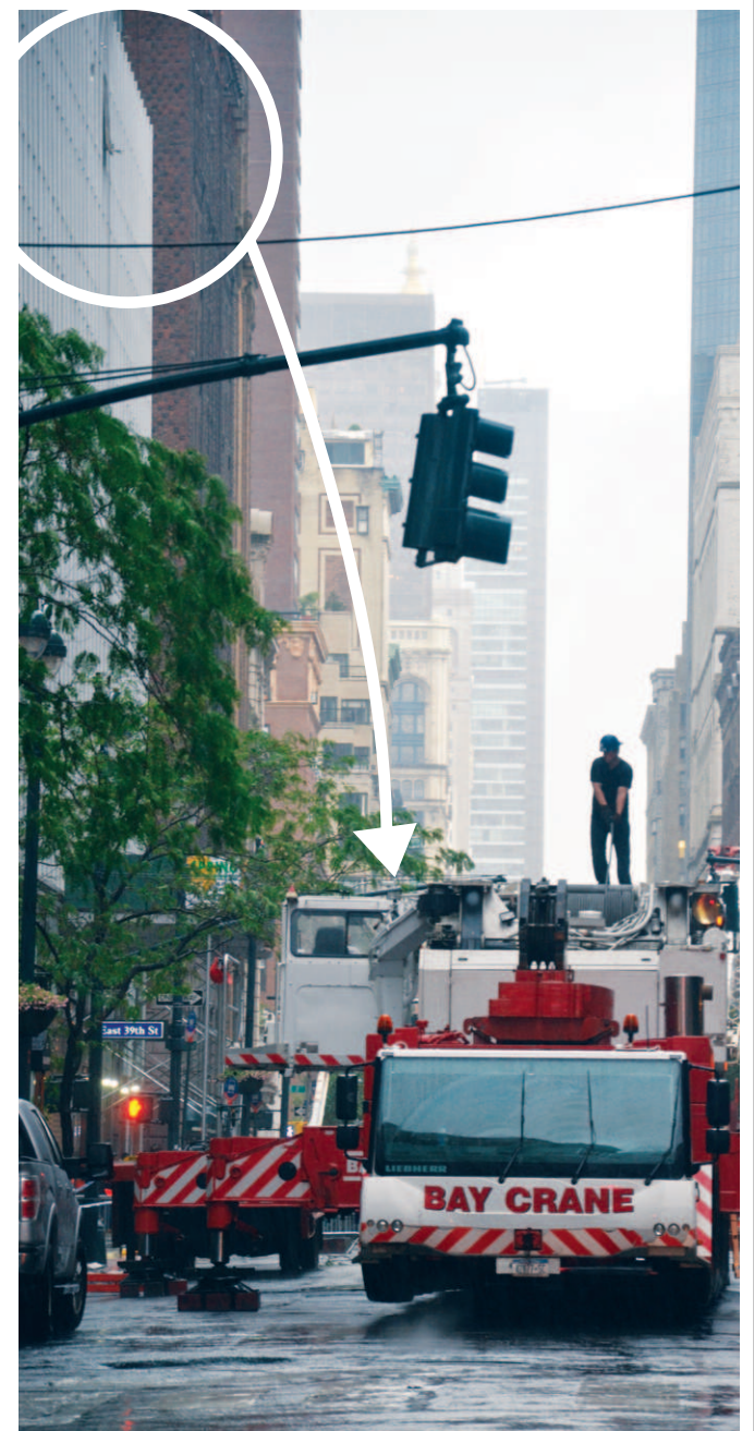
大型エアコンがビル側面(円内)に衝突して落下した
